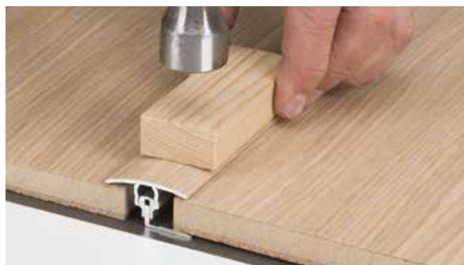
Instalace přechodového profilu hliníkového
