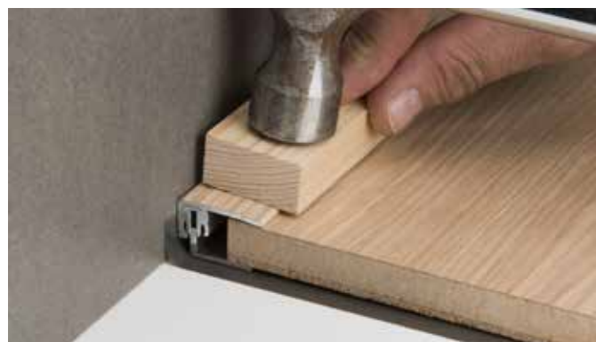
Instalace ukončovacího profilu hliníkového
